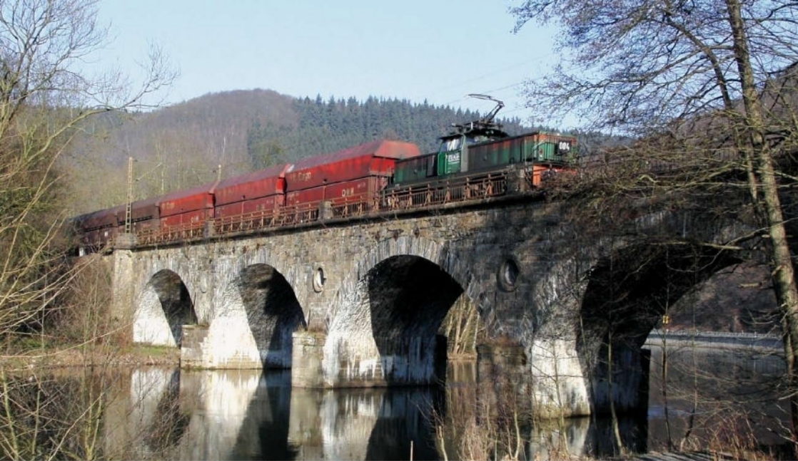
Auf Ihrem Weg von Recklinghausen-Süd zum Kraftwerk Werdol überquert die E-Lok 1200 den Lenneviadukt bei Werdol Utterlingens.
